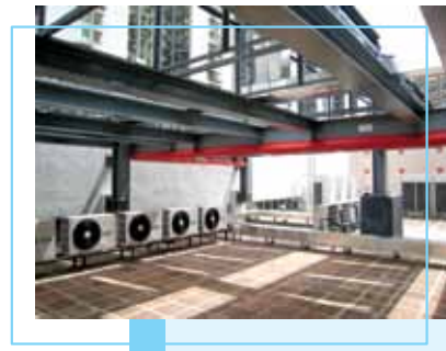
(Figura 9) Espaço envolvente após conclusão da instalação.
