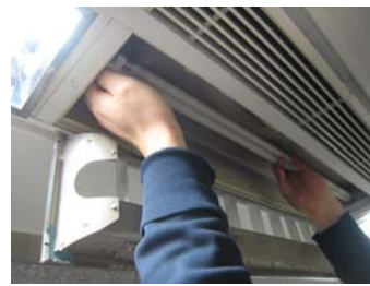
換上附有電子鎮流器的 T5 光管
